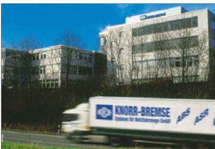
Die Knorr-Bremse Werke in Kecskemét, (Ungarn).
